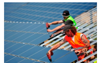
pose des panneaux
