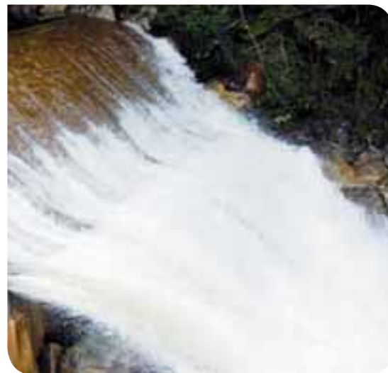
Centrale hydraulique de Scopamène en Corse, France
