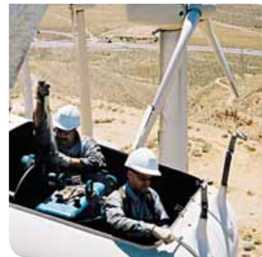
Une opération de maintenance à l'intérieur d'une nacelle aux États-Unis
